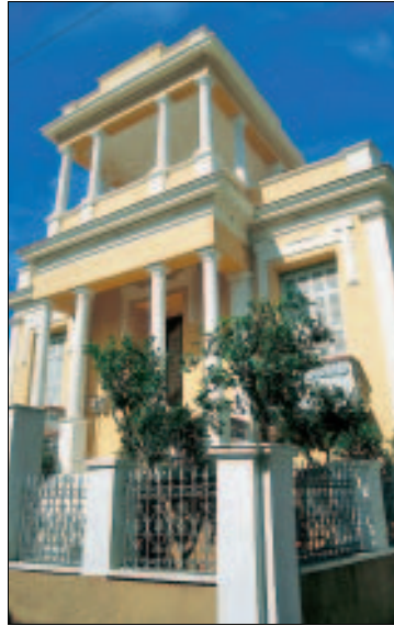
Aufwändig renoviert: typisches Haus
