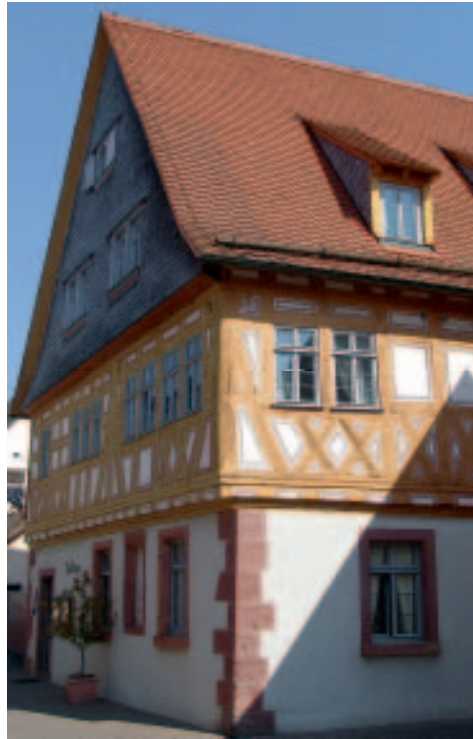
Fachwerk in Dieburg
